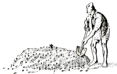
चित्र ५.१५: ढलाईको सुख्खा मसलामा पानी राखी मोल्दै गरेको
