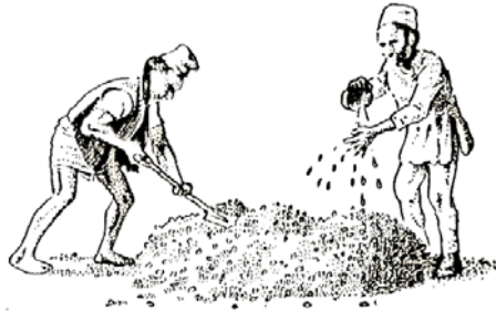
चित्र ५.१६: ढलाई मसलामा पानीको मात्रा छर्कदै गरेको
