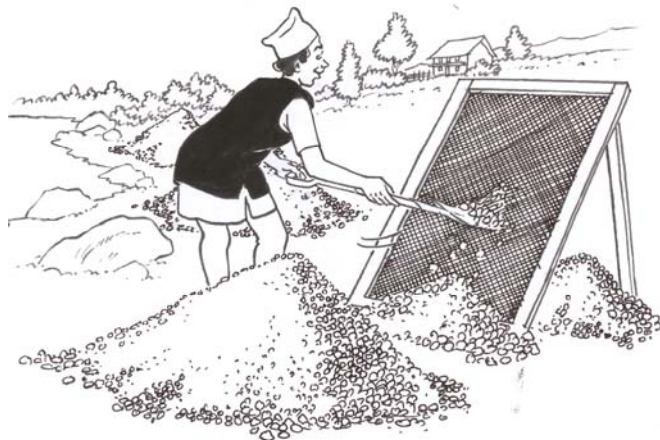
चित्र १.७: खोलाको गिटी जालीमा चाल्दै गरेको
