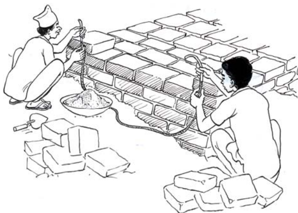
चित्र २.३०: लेभल पाइपले गारोको लेभल जाँच गर्दै गरेको
